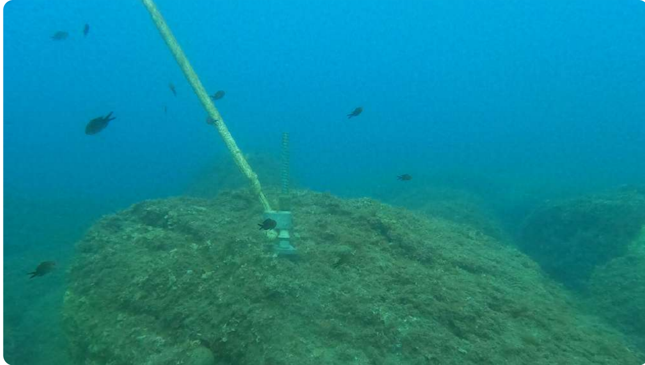
Ancrage dans la roche
